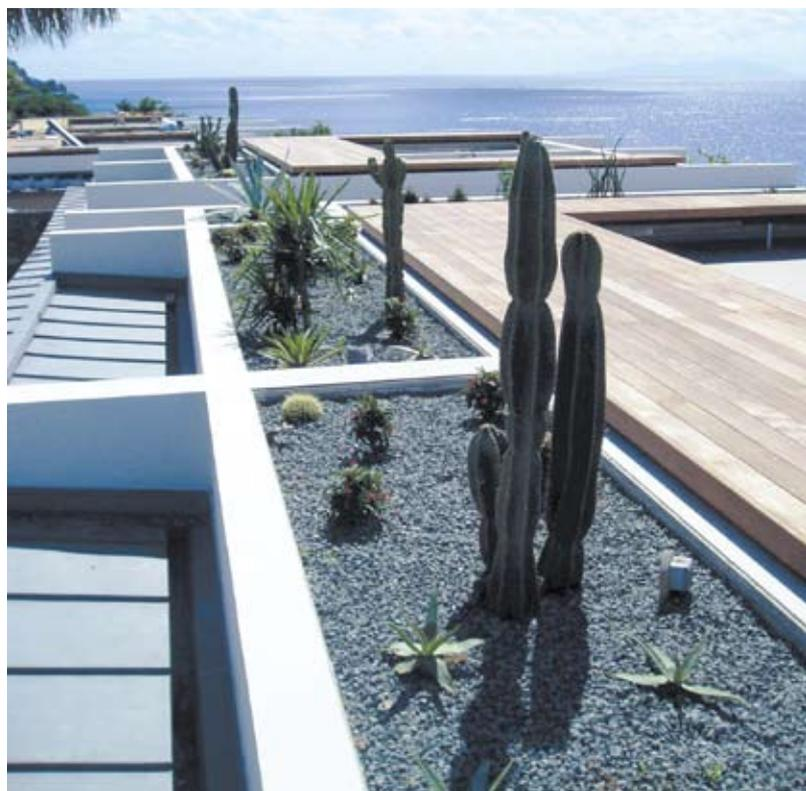
*Dachbegrünungen bieten einen hohen ökologischen Nutzen und verbessern die Energiebilanz von Gebäuden. Die Basis dafür bieten wurzelfeste, witterungsbeständige PVC-Dichtungsbahnen.*
