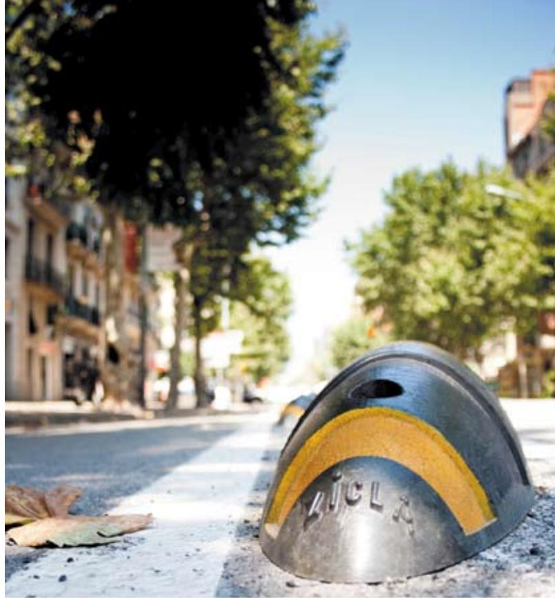
*Dieser praktische Spurentrenner wird aus alten PVC-Kabelummantelungen hergestellt. Auto- und Radfahrer hält er immer in der richtigen Spur. Foto: ZICLA*
